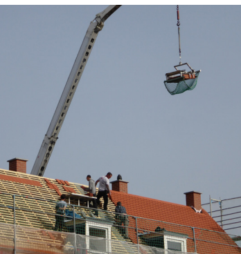
Die Dacharbeiten sind im vollen Gange
