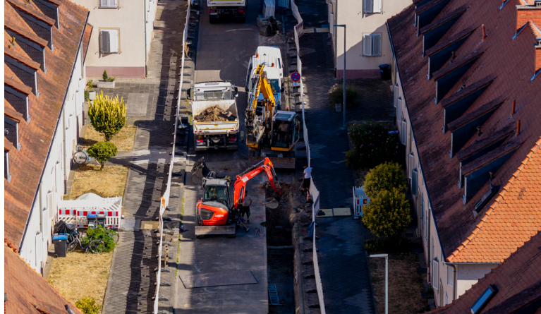
Bagger im Einsatz: In der Christoph-Lehmann-Straße werden Fernwärmeleitungen verlegt (Foto: Klaus Venus)
