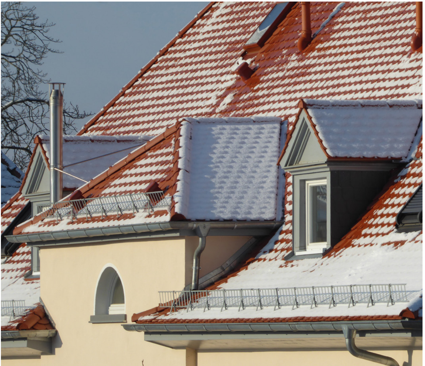
Durch energetische Sanierung ist das Gebäude Am Woogbach 3 und 4 für den Winter gut gerüstet
