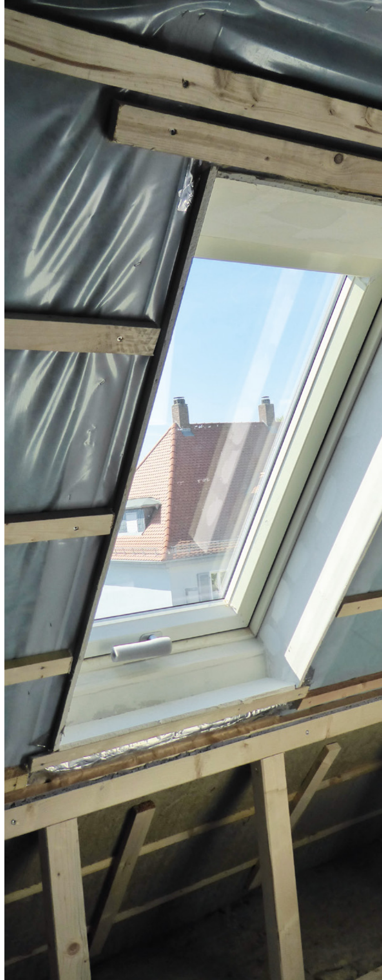
Sanieren im Bestand: Dachdämmung verbessert die Energiebilanz und schont Ressourcen
