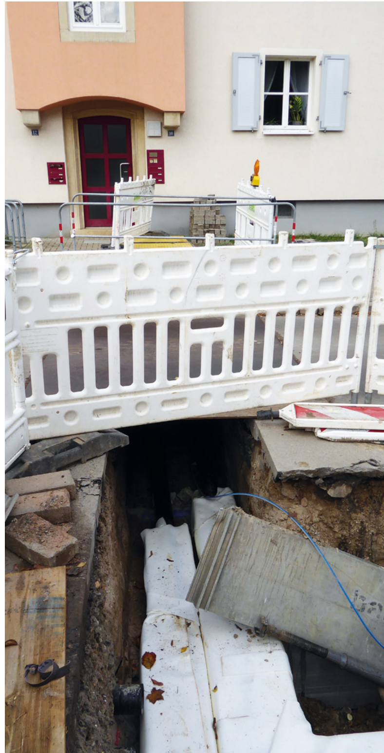
Gerade im historischen Bestand der GBS eröffnet der Ausbau der Fernwärme Perspektiven für eine klimafreundliche Wärmeversorgung – hier in der Josef-Schmitt-Straße
