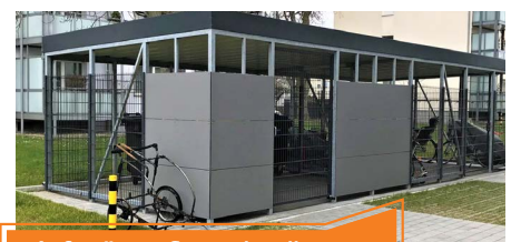
Aufgeräumt: So werden die neuen Einhausungen aussehen
