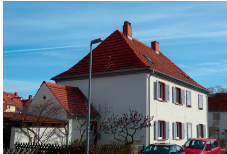
August-Becker-Straße 2-4 nach erfolgter Sanierung
