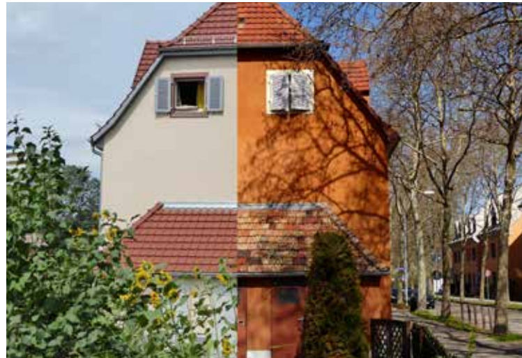
Das Gebäude Burgstraße 29–31 nach (links) und vor der Sanierung (rechts)
