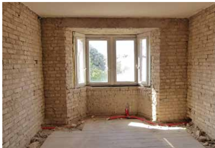
Das Wohnzimmer einer Wohnung in der Blaulstraße 32 während und nach der Sanierung
