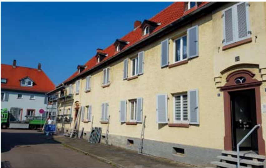
Im Zuge der Gebäudesanierung werden in der August-Becker-Straße 6–12 Gerüste gestellt.
